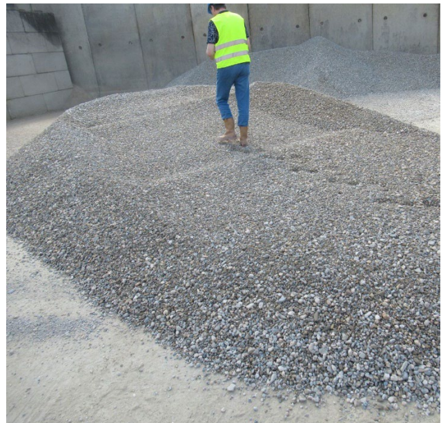
Foto 10. Vlaktrekken kegel depot
